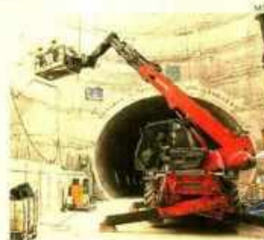
Más alta. Se transferirán S/ 482.2 millones del proyecto de la Línea 2 del Metro a gobiernos subnacionales.
